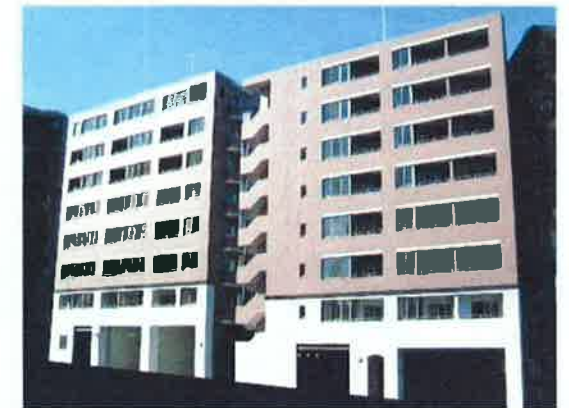
外観(S棟:左側 / N棟:右側)
